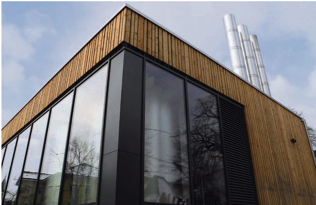
Eines von vielen Puzzlestücken im Energierichtplan: Die Heizzentrale des Nahwärmeverbunds Zentrum. (FUP)
